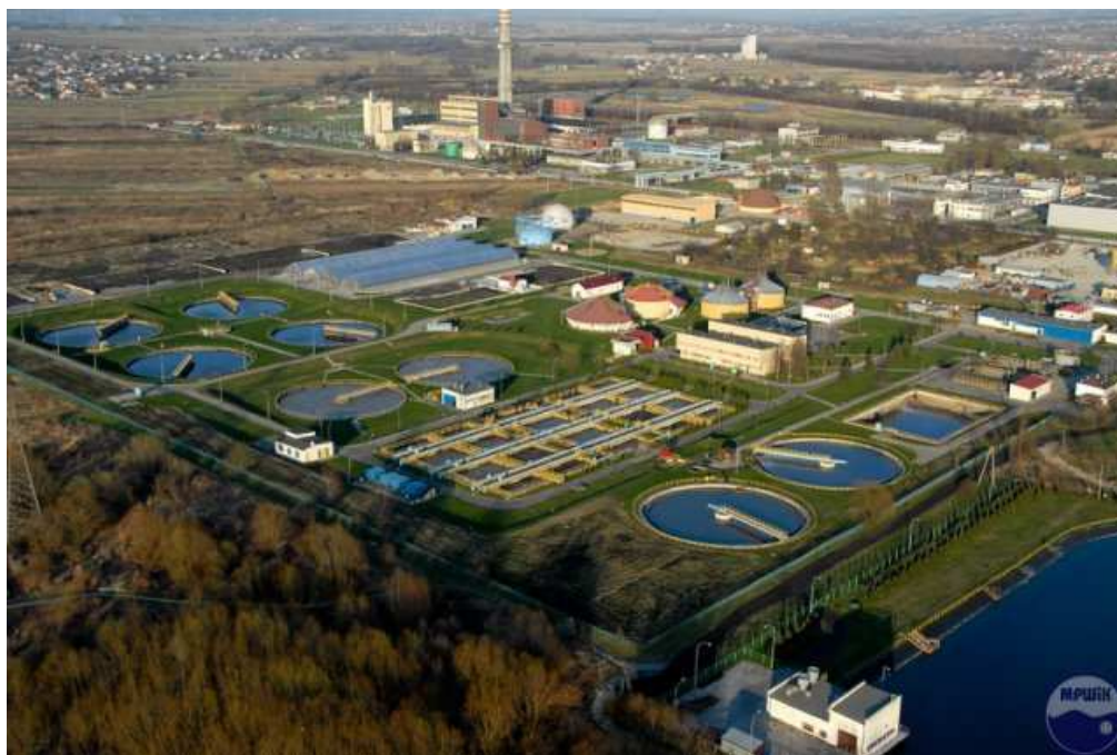
Fot. 2. Oczyszczalnia Ścieków Miejskiego Przedsiębiorstwa Wodociągów i Kanalizacji w Rzeszowie 31
