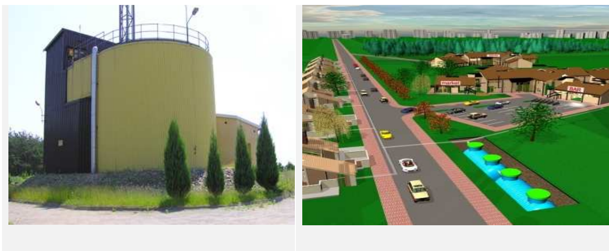
RYСУNEK 22. OCZYSZCZALNIA, W KTÓREJ PROCES BIOLOGICZNEGO OCZYSZCZANIA ŚCIEKÓW ODBYWA SIĘ NA ZŁOŻU ZRASZANYM.
