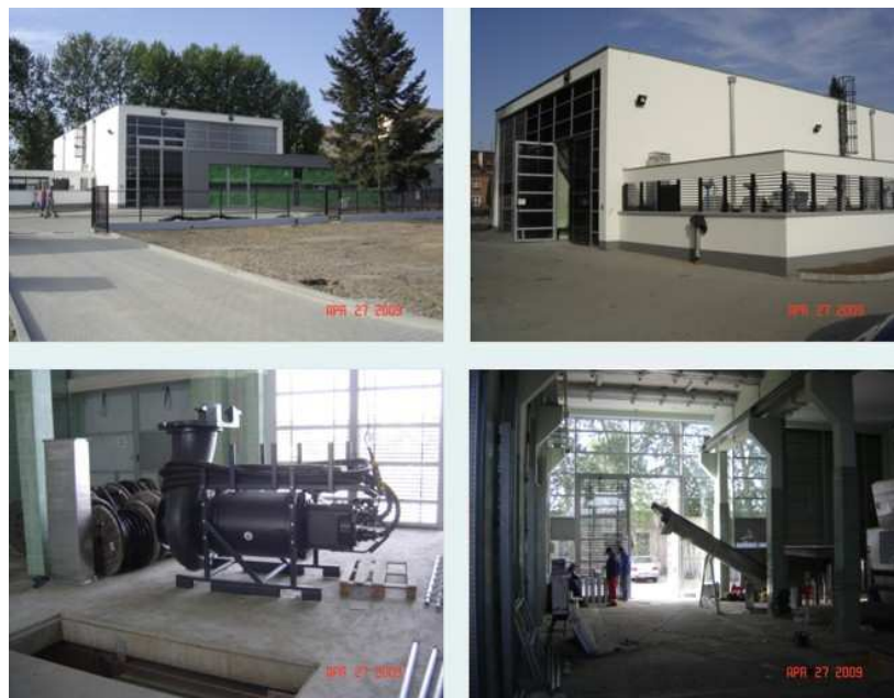
RYSUNEK 7. POMPOWNIĄ ŚCIEKÓW GRABÓW.
