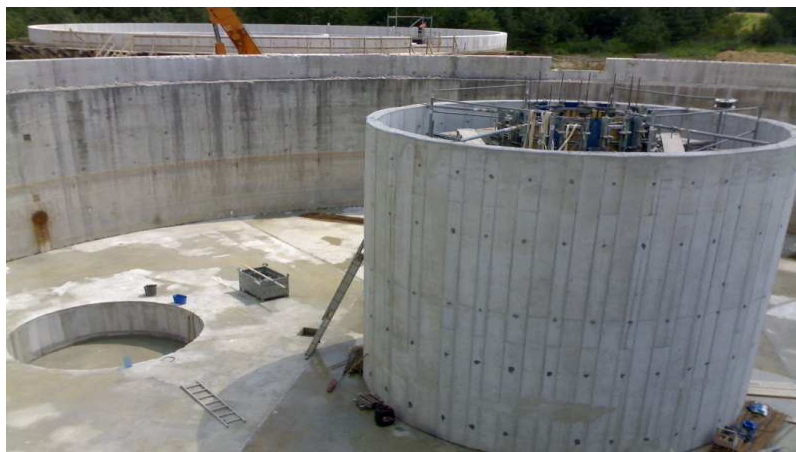
Fot. 8. Tarnowskie Góry, Budowa oczyszczalni ścieków.
