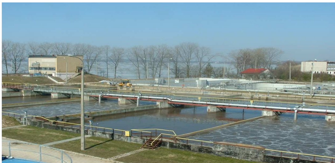
Fot. 1. Oczyszczalnia ścieków - Giżycko 19
