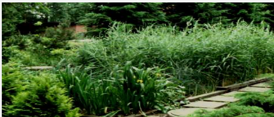
RYСУNEK 18. OSADNIK GNILNY, OCZYSZCZALNIA BAGIENNA (KORZENIOWA).
