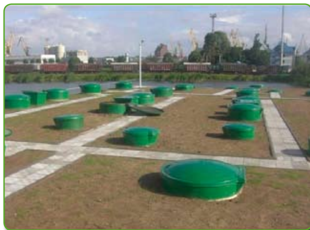
ZBIORNIKI Z LAMINATU POLIESTROWO-SZKLANEGO (GRP) DO 200 m 3 WYKONYWANE NAJNOWOCZĘSZĄ TECHNOLOGIĄ NAWIJANIA KRZYŻOWEGO
